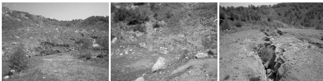
Fig. 54. Elemente ale alunecării de pe halda de la Câmpu lui Neag (a. Cleionaj distrus în fruntea alunecării, b. Fruntea alunecării, c. Crăpături profunde în masa haldată, în sectorul râpei de desprindere)
