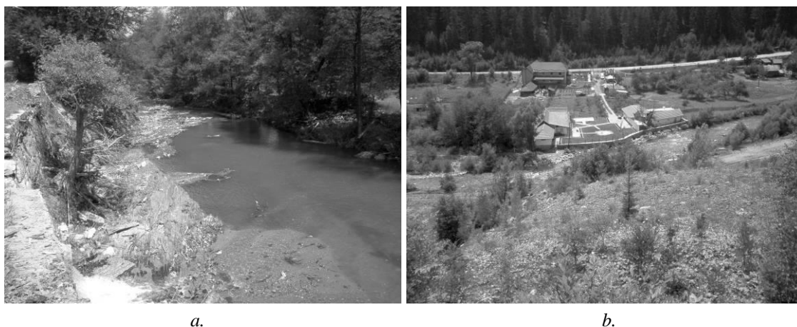
Fig. 93. a. Jiul de Vest, între Câmpu lui Neag și Valea de Brazi - potențial de obturare a albiei cu deșeuri lemnoase; b. Construcții noi, expuse inundațiilor, în lunca Jiului de Vest (amonte de Câmpu lui Neag)
