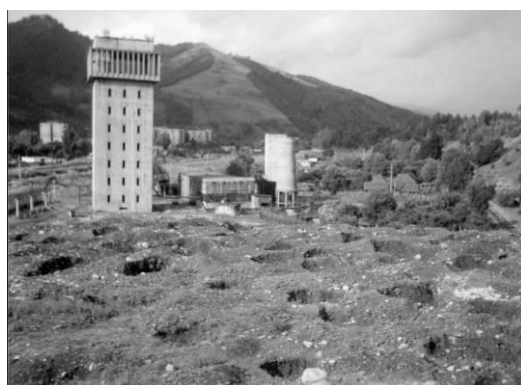
Fig. 55. a. Tasare pe o haldă din perimetrul minier Petrila; b. Eroziune în adâncime pe o haldă de steril din perimetrul minier Câmpu lui Neag
