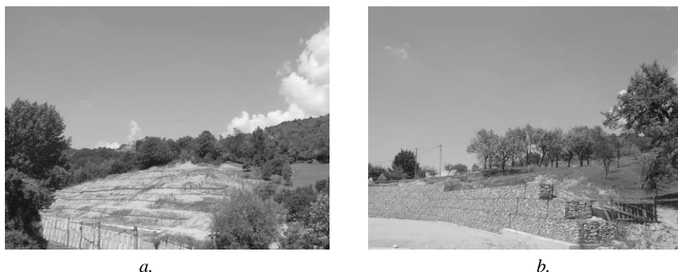
Fig. 139. a. Cleionaje și canale de drenaj pe un versant instabil, la Bănița (pe dreapta CF Petroșani-Simeria); b. Enrocamente pe E79, la Bănița, într-un sector afectat de alunecări de teren
