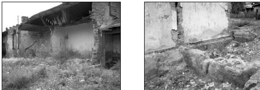
Fig. 57. Locuințe afectate de subsidența indusă în cartierul Ștefan din Lupeni
