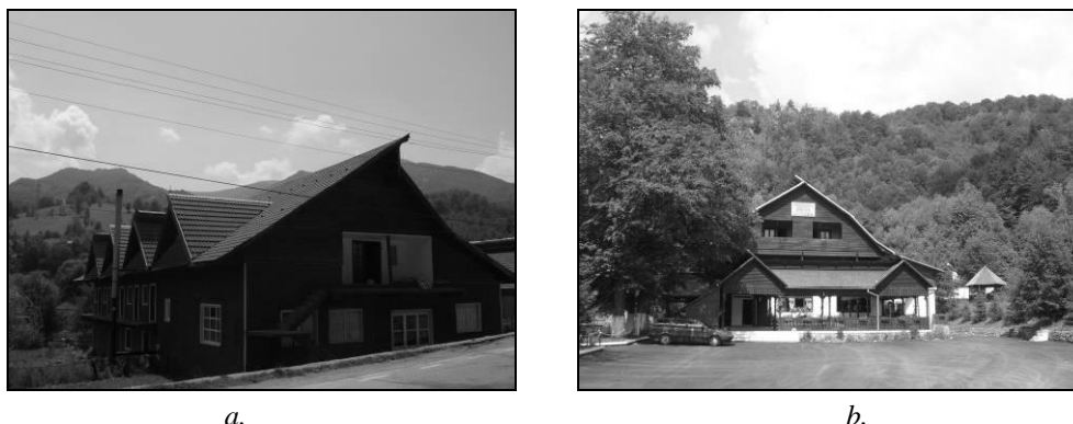
Fig. 138. a. Pensiune în construcție la Valea de Brazi; b. Complexul turistic Cheile Buții – Câmpului Neag
